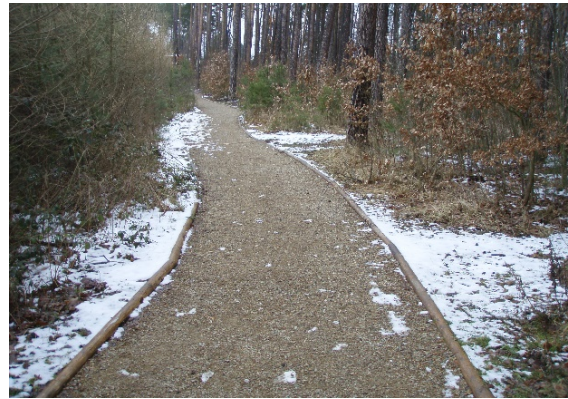
Obr. 37: Povrch cest z MZK s bočním zpevněním
