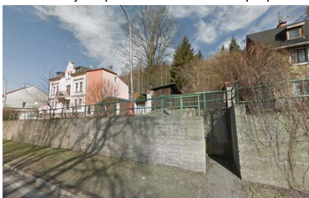
Obr. 34: Prostup v opěrné zdi na Karlovarské ul.
