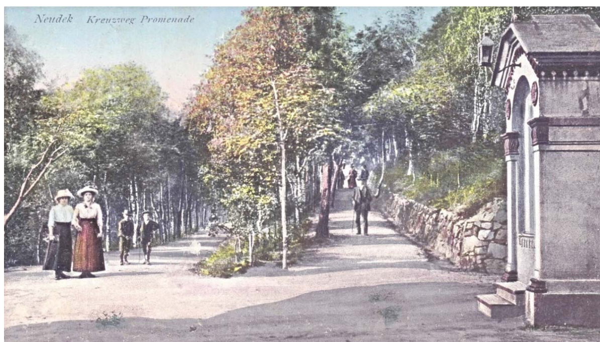
Obr. 13: Dobová kolorovaná pohlednice křížové cesty s kamennými opěrnými zídkami a osvětlením kapliček
