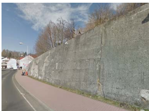
Obr. 58 a 59: Vysokou železobetonovou opěrnou konstrukci opěrné zdi doporučujeme při rekonstrukci v části rozdělit na dvě výškové úrovně a k začlenění do okolí použít popínavou zeň.
