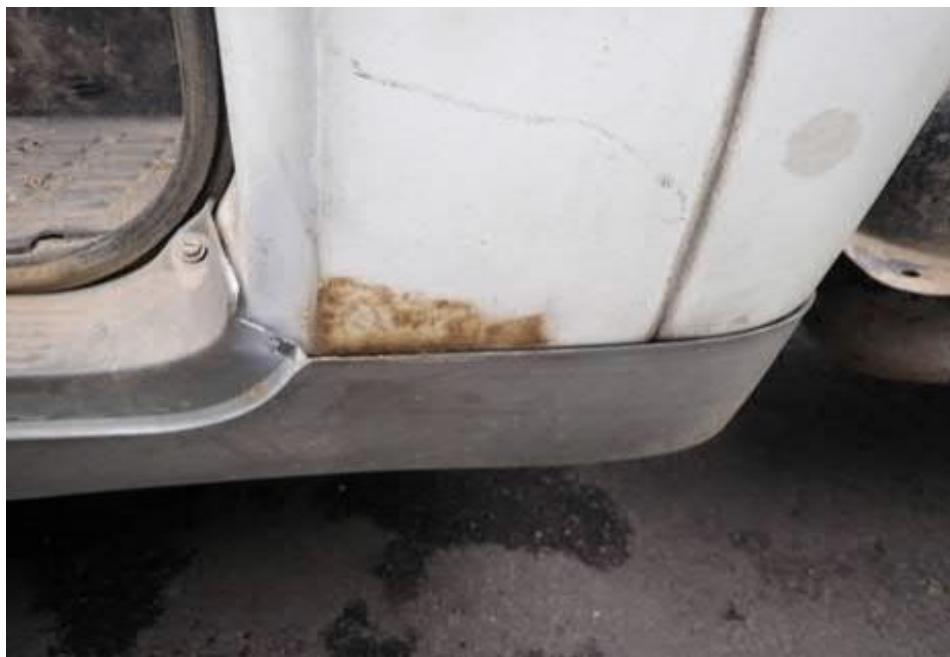
levý sloupek "B" zkorodován
