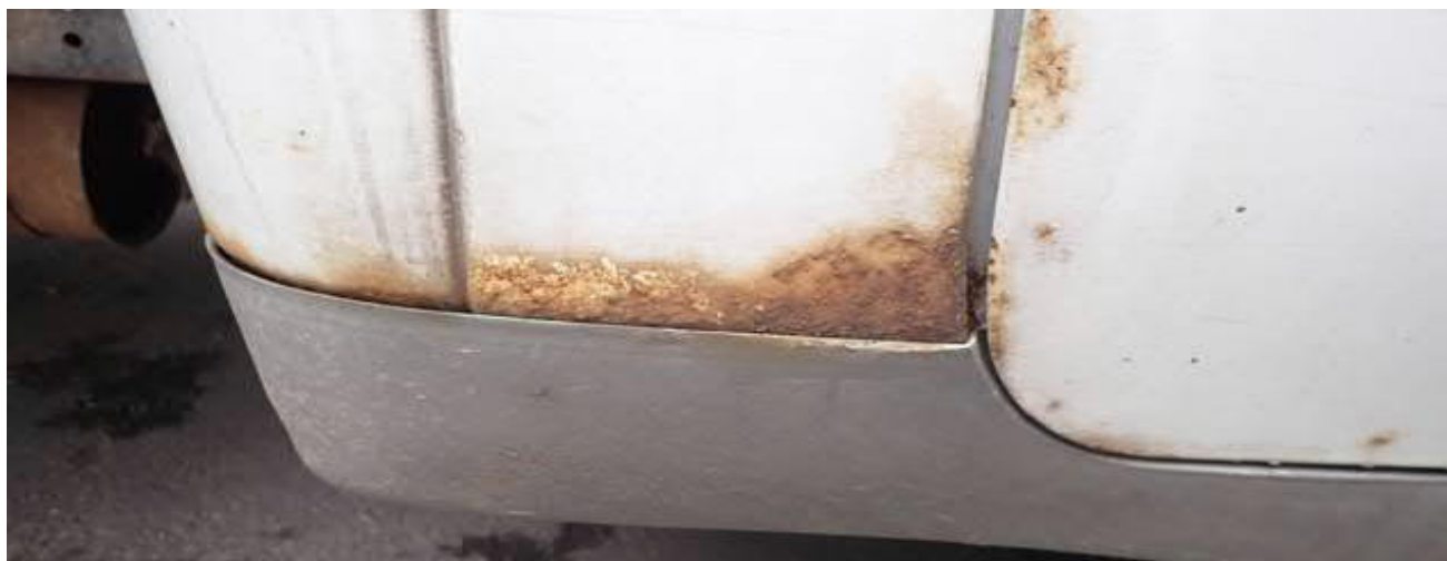
pravý "B" sloupek zkorodován
