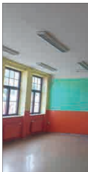
Třída před rekonstrukcí
