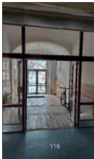
Vestibul před rekonstrukcí
