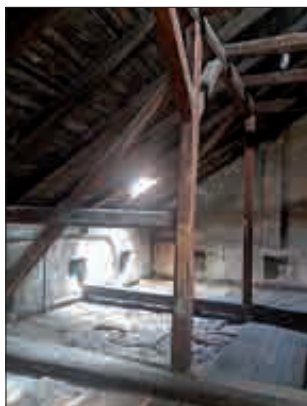
Podkroví před rekonstrukcí – budoucí sborovna
