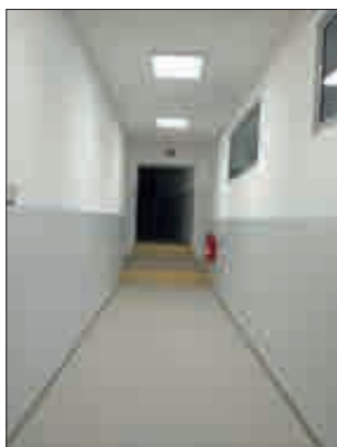
Chodba 2. NP po rekonstrukci
