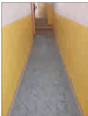
Chodba 2. NP před rekonstrukcí
