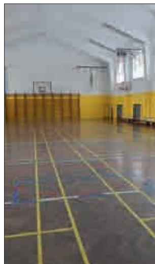
Velká tělocvična před rekonstrukcí
