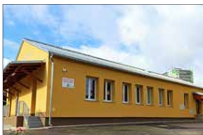
Vnější část objektu po realizaci rekonstrukce
