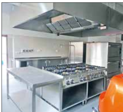
Vnitřní část objektu po realizaci rekonstrukce
