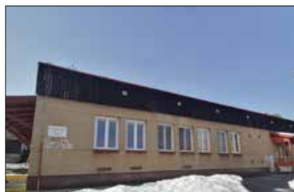
Vnější část objektu před realizací rekonstrukce
