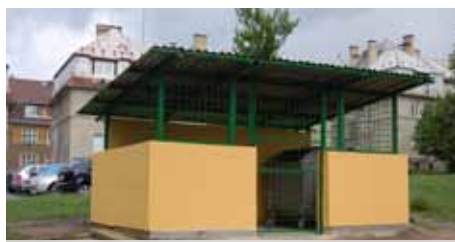
kompletní oprava popelnicového boxu v ulici J.A.Gagarina
