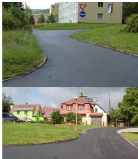
obnova asfaltového povrchu spojky mezi Okružní a Karlovarskou
