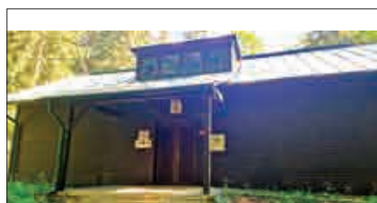
Úprava vody Limnice
