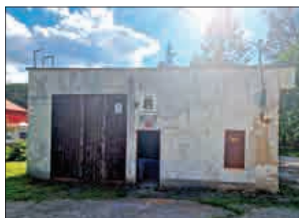
Úprava vody Vysoká Pec
