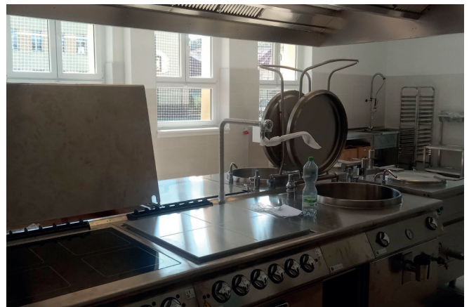
Zrekonstruovaná školní jídelna a nové gastrovybavení – ZŠ náměstí
