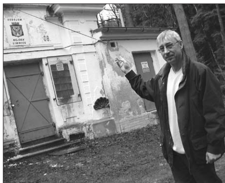
Pracovník firmy Ayin, s.r.o., Ing. Lubomír Vítek před úpravnou vody na Limnici.
