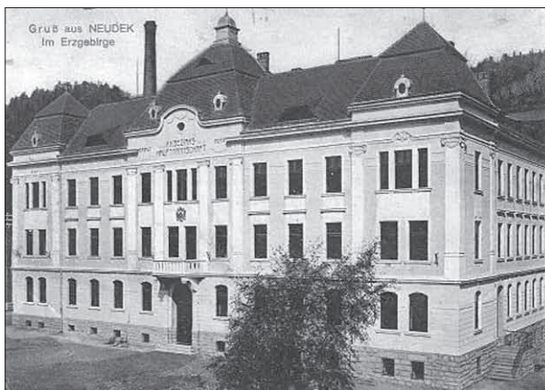
Na vystavbě budovy okresního hejtmanství se podílela stavební firma Seitz Karlovy Vary a Möckl Nejdek, foto krátce po roce 1910.
