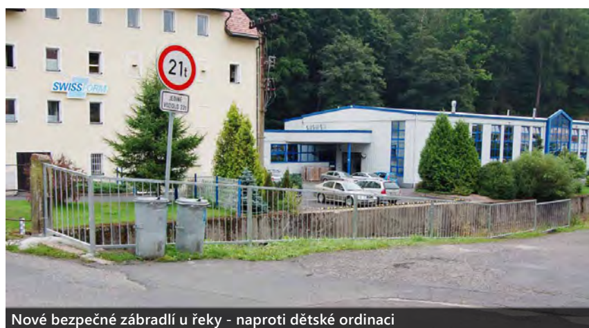
Nové bezpečné zábradlí u řeky - naproti dětské ordinaci
