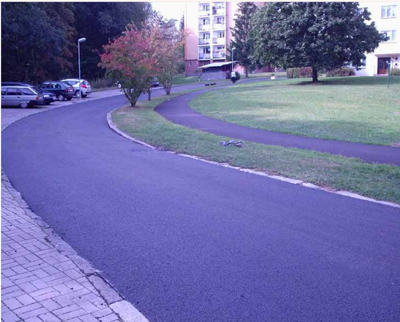
Oprava komunikace v Okružní ulici.
