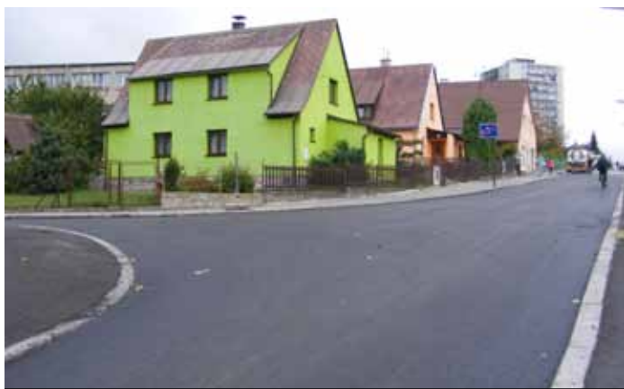
Oprava komunikace v ul. Lipová a Okružní. Foto: Ivana Cimprichová
