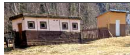
Stávající nevyhovující hygienické zázemí: vlevo WC, vpravo sprchy
