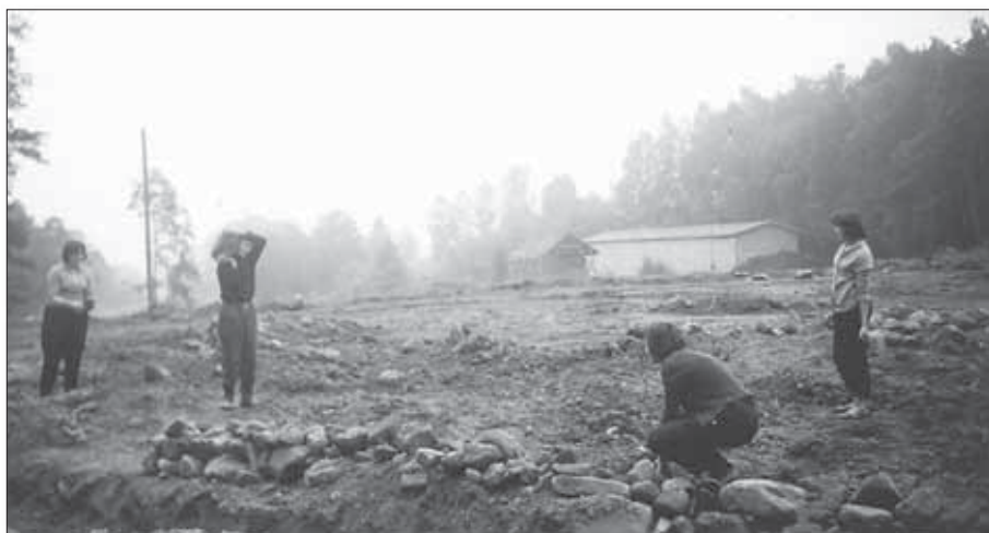
Budování kurtů – práce na drenážích.
