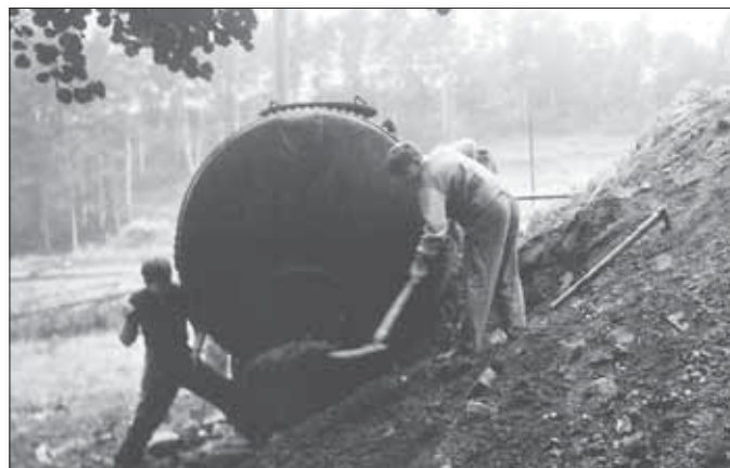
Výstavba tenisových kurtů – ukládání nádrže na vodu pro postřik kurtů.
